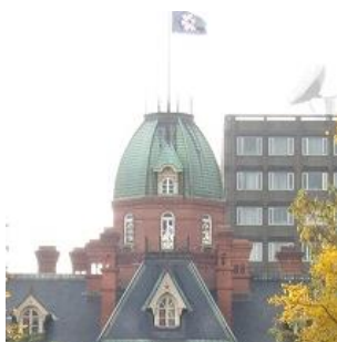
現在（改修工事前）
